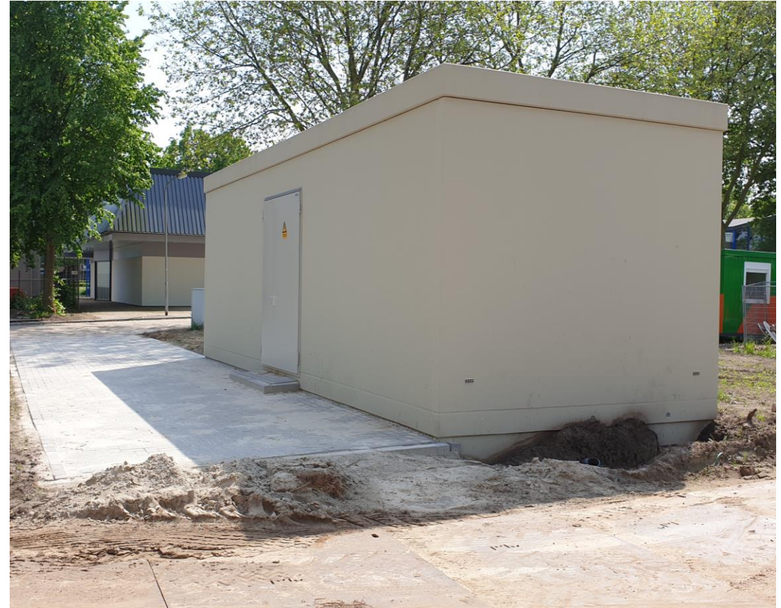
Afbeelding: schakelstation in Borger
