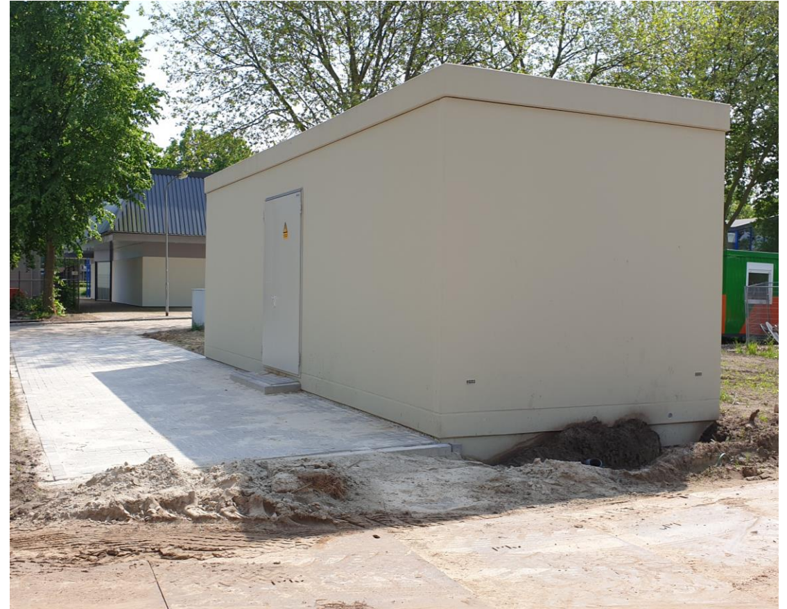
Afbeelding: schakelstation in Borger
